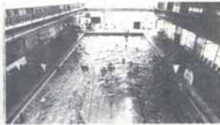
یکی از دواستخر سر پوشیده مجموعه
